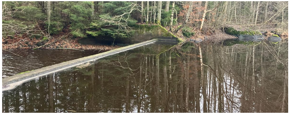
Figur 4. Befintligt betongdämme - foto taget från uppströmssidan.
