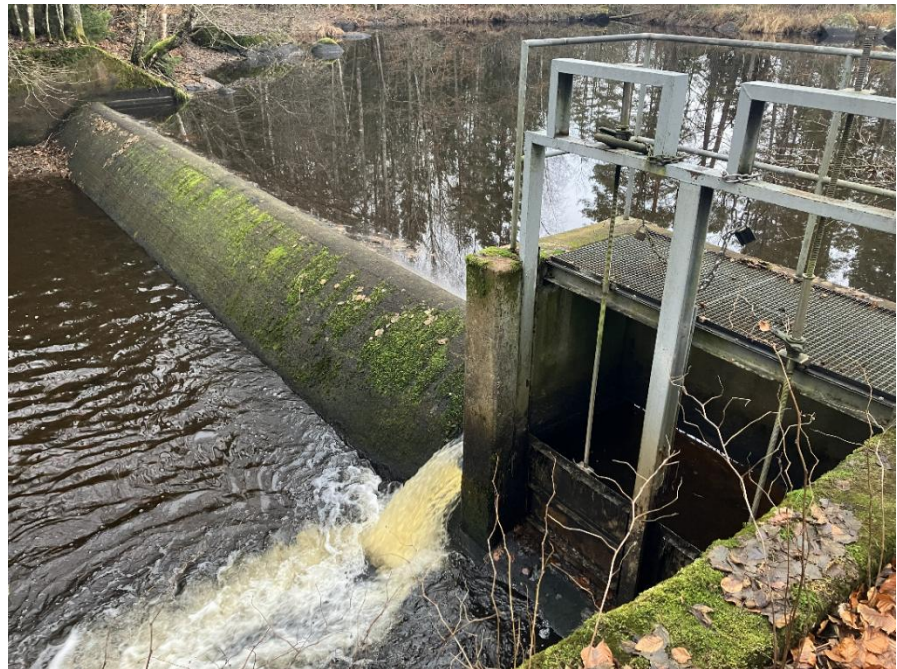
Figur 3. Befintligt betongdämme med mintappningsrör och utskov. Foto taget från nedströmssidan.
