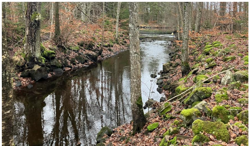
Figur 5. Sträckan i Bräkneån från befintligt utlopps-dämme och cirka 50 m nedströms.
